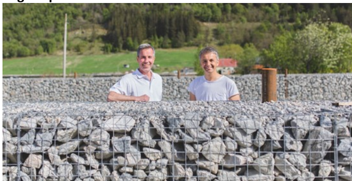
Ole-Kristian Hess-Erga (f.v.) og Jan Arne Brekke i Sogn Aqua: På det landbaserte anlegget i Ortnevik bygde Sogn Aqua over éin med gabionveggar. Dette er nettingkassar som vart fylt med stein frå nærområdet. (Foto: Kind).
