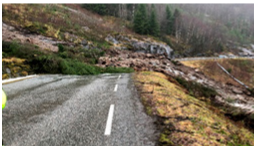
Fv 5406 ved Kallestad bru i februar 2010.
