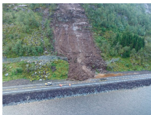
Bildet viser eit fanggerde som vart øydelagt av eit stort skred på E 39 ved Drægebøvatn i 2016.
