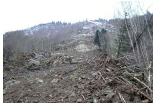
Fv 550 Eikhamrane nord, vestsida av Sørfjorden, 26 desember 2011
