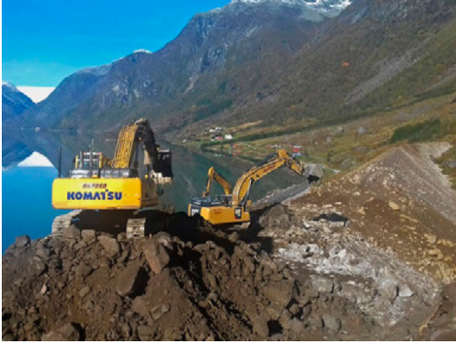
Fv 5641. Bygging av skredvoll ved Veitastrondsvegen.
