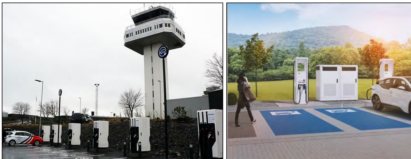
Figur 5 (venstre): Deltaladarar med tre uttak og effektdeling på drosjedepot ved Bergen lufthamn - Foto: Thomas J Potter. Figur 6 (høgre): 350 kW Ladar frå ABB.
