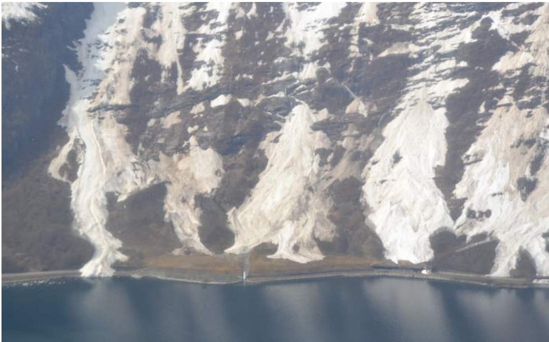
Bilde 2: Skred i Velure Fv. 550. Foto: Jens Tveit, Statens vegvesen
