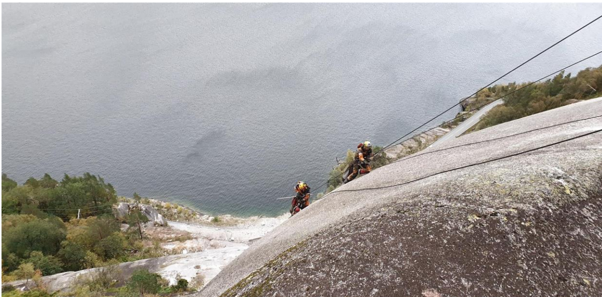
Bilde 5: Skredsikring ved Rv. 13, Lauvik i Rogaland. Foto: Agnes Selma Haker, Statens vegvesen
