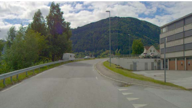
Fv. 5613 Dalavegen i Sogndal – smalt og slitt fortau Foto: Statens vegvesen
