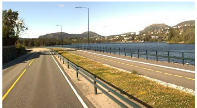
Bilde 2: Fv. 574 Bjørgeveien i Bergen – sykkelveg med fortau
