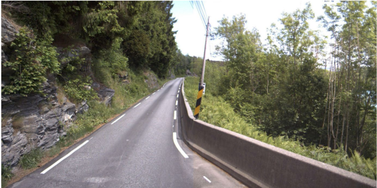
Figur 10 Situasjonsbilde frå strekning 2, Årsnes - Furevika. Smal strekning øst for Mundheim med blant anna eit knip med vegbreidde under 4 meter. (Statens vegvesen/vegilde)
