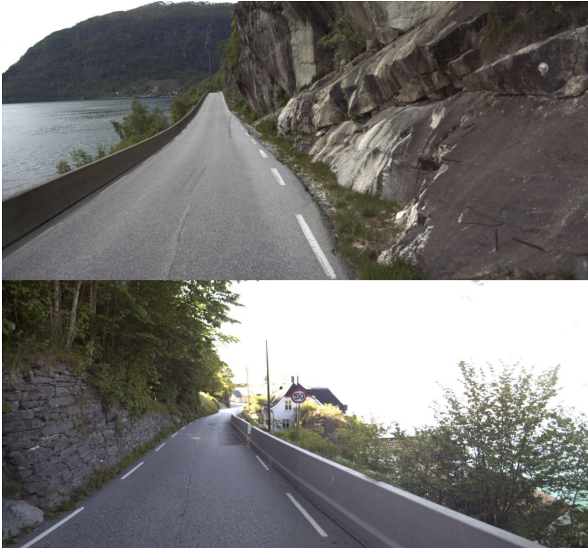
Figur 8 Bileta over viser eksempel frå fv. 79 frå Sauaneset og Steinstø som illustrerer utfordringa med bratt sideterreng og busetnad tett på vegen. Dette er ofte situasjonen på store deler av desse strekkjene (frå Statens vegvesen/vegilde)
