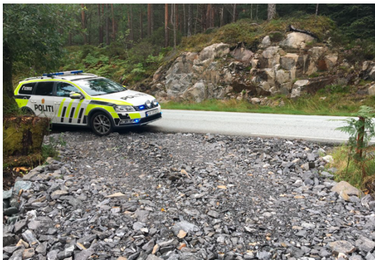
Anlagt veg fra gbnr 21/237 inn mot Fv 562.
