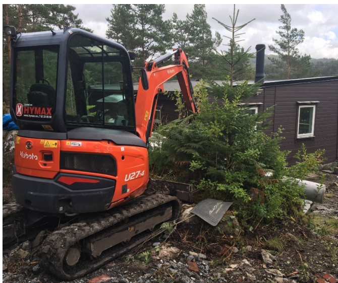
Parkert gravemaskin på gbnr 21/237
