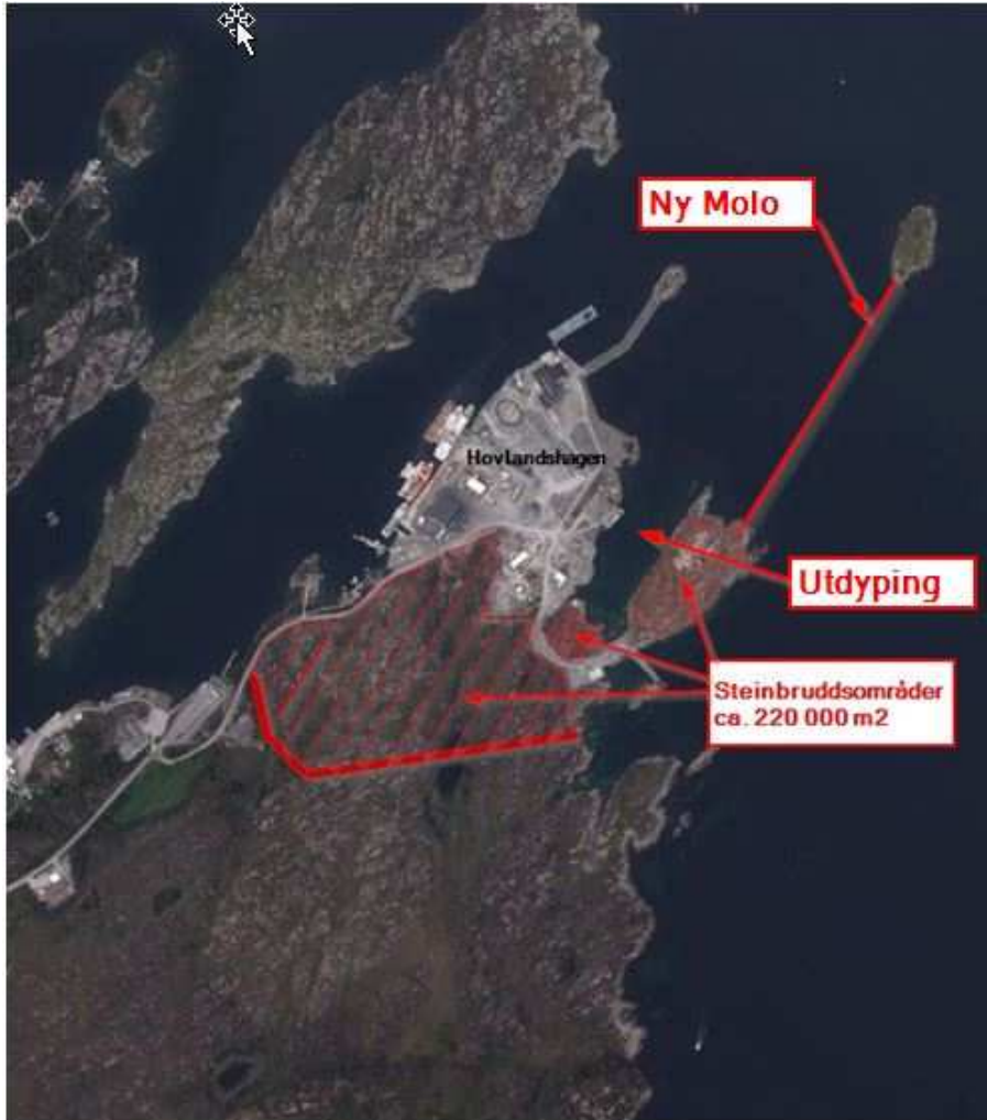
Bildet viser tiltak i forbindelse med bygging av ny fiskerihavn.
