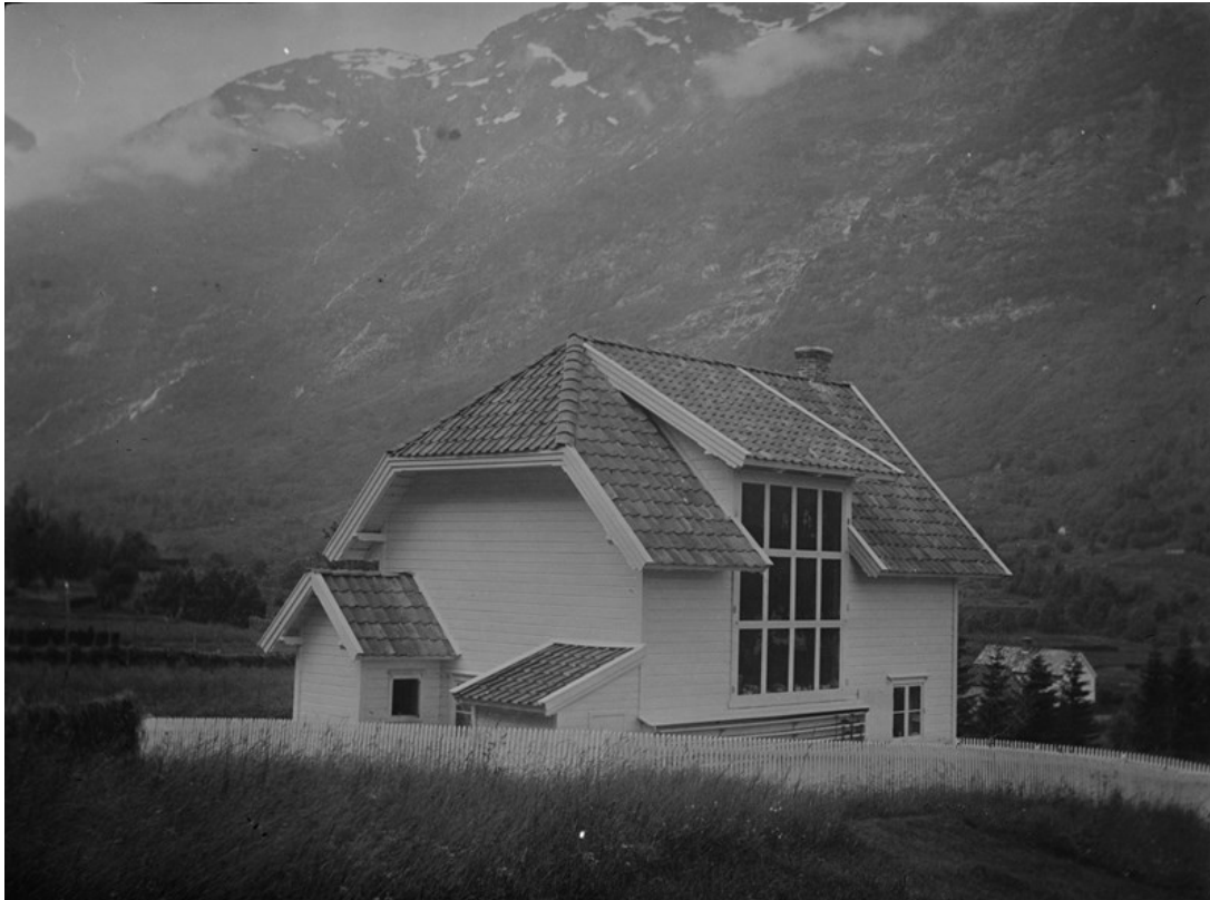
Studio før det midterste tilbygget mot aust vart bygd. Foto frå Fylkesarkivet i Sogn og Fjordane.
