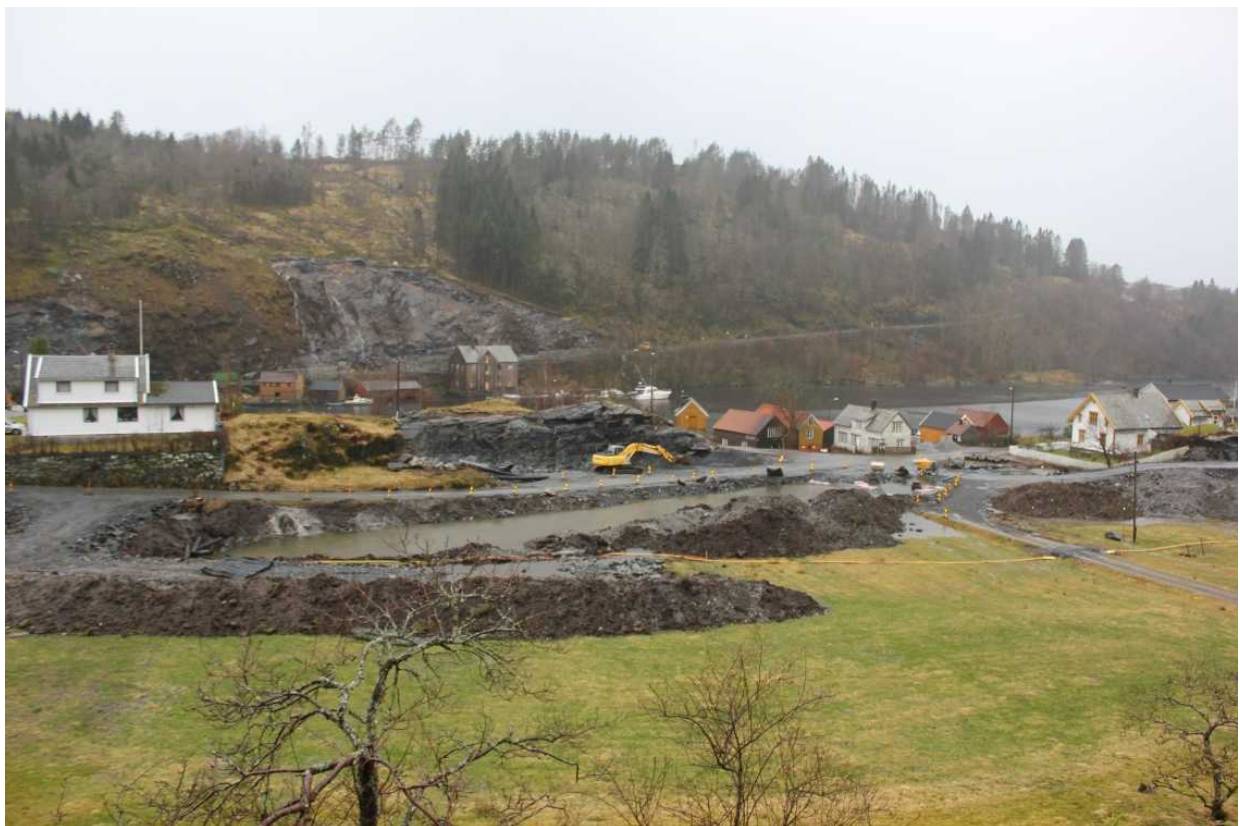
På 89/5 er matjordlaget lagt til sides før bygging av ny veg og deponering av massar.
