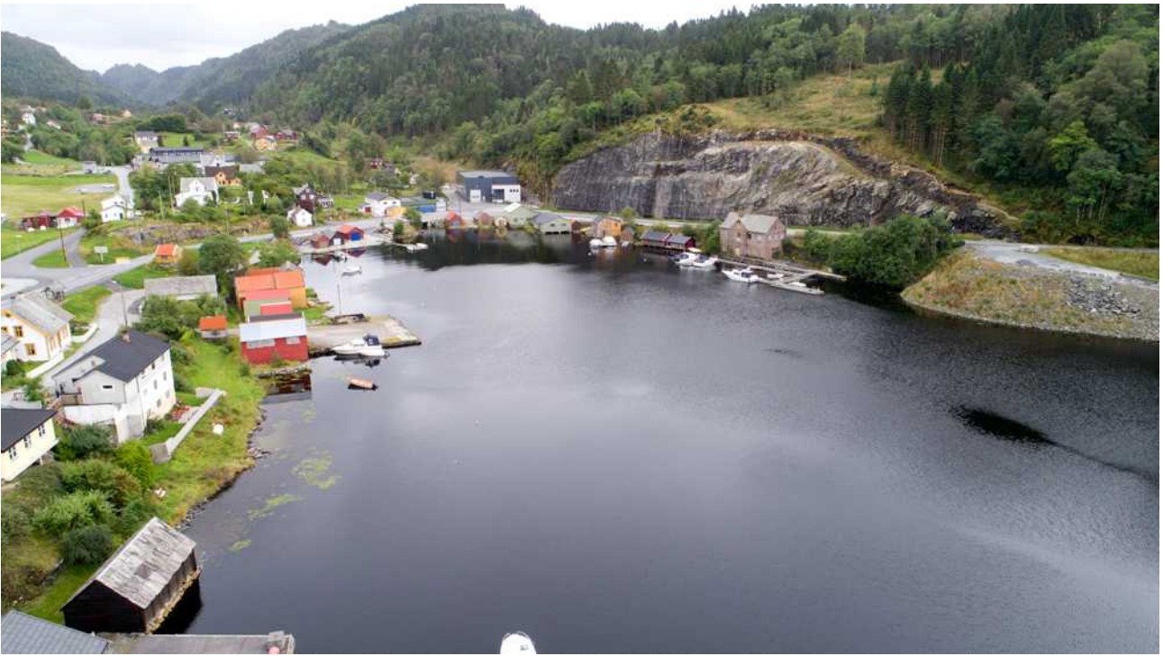
Den nye avkøyringa til Refsneset på fylling til høgre.
