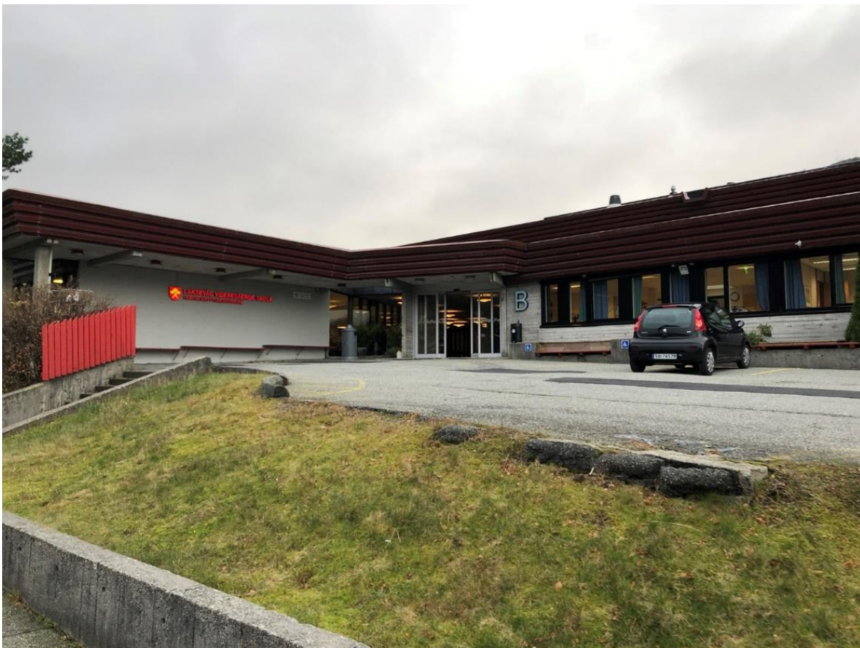
Figur 26: Fasade mot nordøst. Viser inngangsparti, vindusrekke samt takstikk/baldakin langs fasade mot den åpne plassen foran inngangen. Foto Norconsult 2018.
