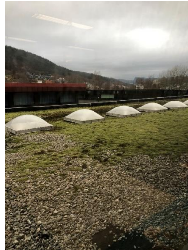
Figur 24: Bilder av taket som viser blant annet åpning til lysgård og overlys samt det karakteristiske taklandskapet med grusdekke. Foto Norconsult 2018.
