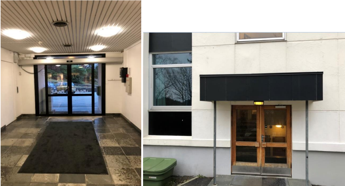
Figur 9: Nyere inngangsparti mot vest, sett innenfra. Inngangsparti i sør med original teakdør med baldakin. Foto Norconsult 2018.
