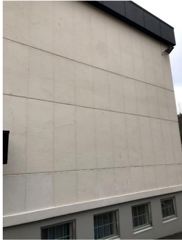
Figur 6: Fasade i sør som viser nye vinduer og platepanel samt rutemønster i betong. Foto Norconsult 2018.
