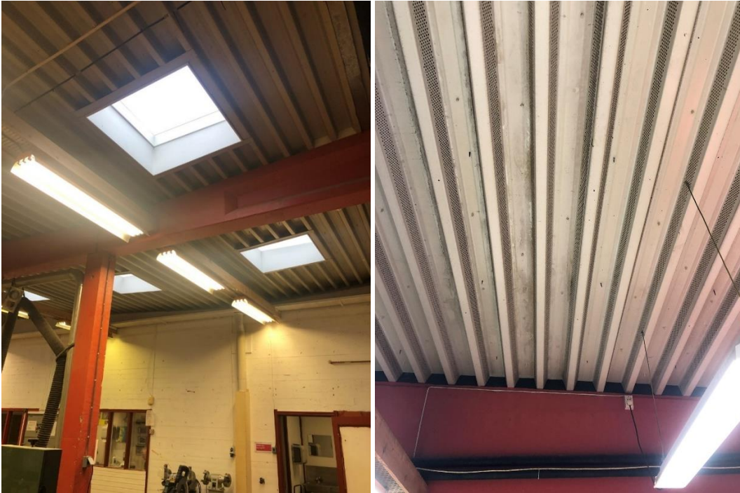
Figur 34: Verksted med overlys, malte betongvegger og profilerte stålplater i tak (Q-dekk). Foto Norconsult 2018.
