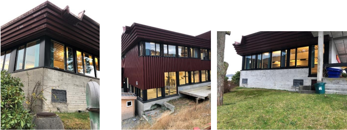
Figur 25: Bilder som viser fasader og gesims med de karakteristiske profilerte fasadeplatene i metall. Foto Norconsult 2018.
