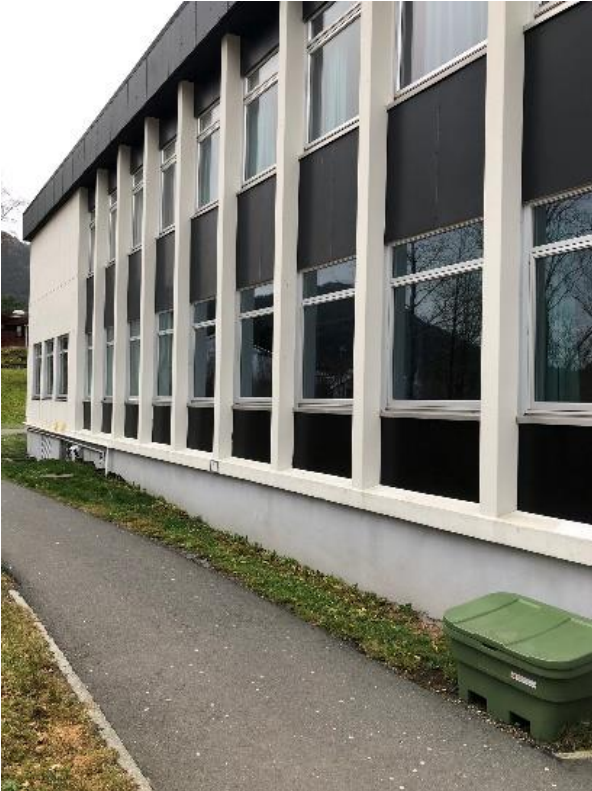
Figur 6: Fasade i sør som viser nye vinduer og platepanel samt rutemønster i betong. Foto Norconsult 2018.
