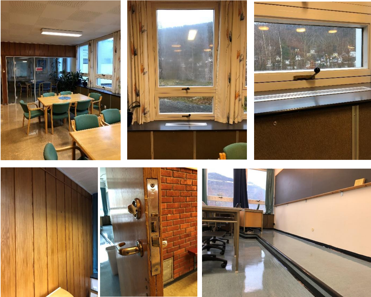
Figur 18: Detaljer fra interiør i klasserom, pauserom, kontor samt detalj av vinduer og dører. Original. Foto Norconsult 2018.
