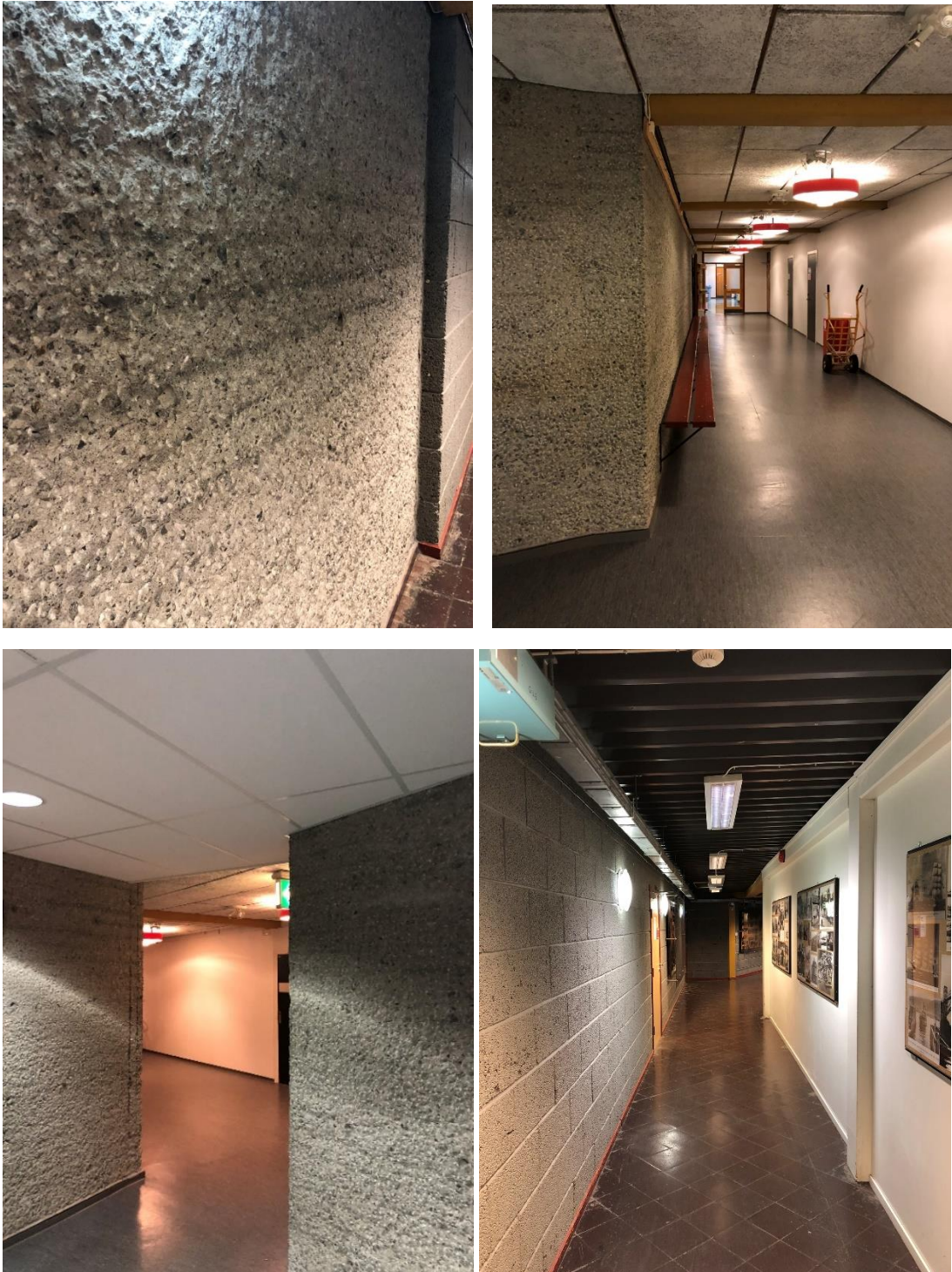
Figur 30: Korridor 1.etajse med originale trebenker samt original dør i enden av korridoren. Bilde av detalj meislet betongvegg. Foto Norconsult 2018.
