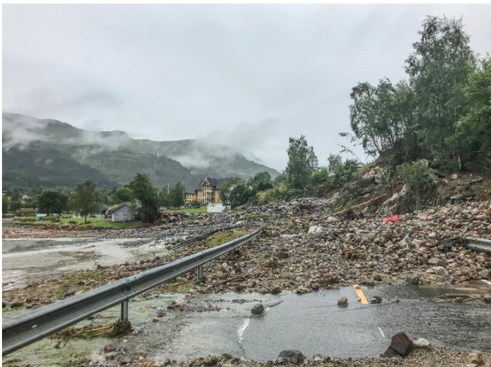
Bilde 4: Fv. 60 Utvik, 2017. Foto: Silje Drevdal, Statens vegvesen
