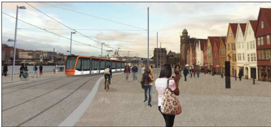
Bryggen sett fra Nikolaikirkeallmenningen. Situasjon med tosidig masteplassering og wirestrekk for kjøreledninger.
