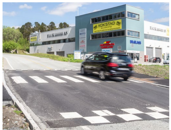
Sikring av kryssingspunkt i Kokstadvegen. Foto: Silje Drevdal
