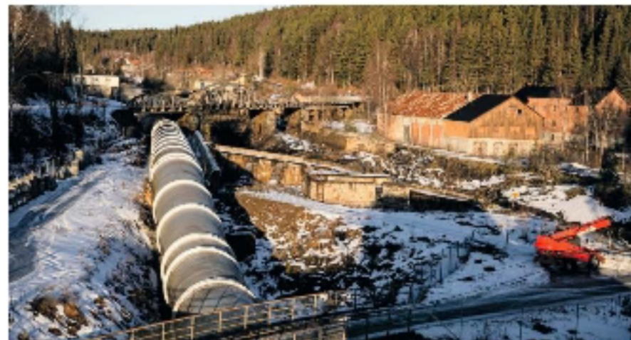
Rørgaten som leder vannet inn til Hensfoss Kraftstasjon.
