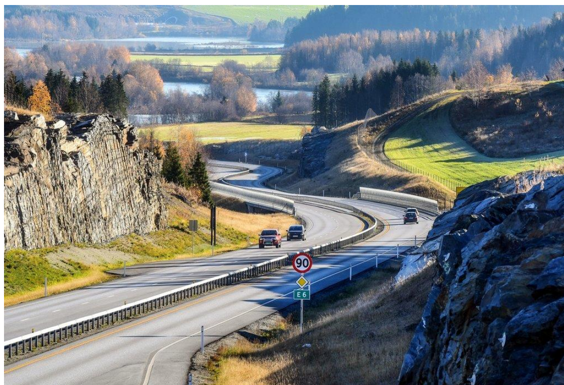
Foto: Knut Opeide, Statens vegvesen
