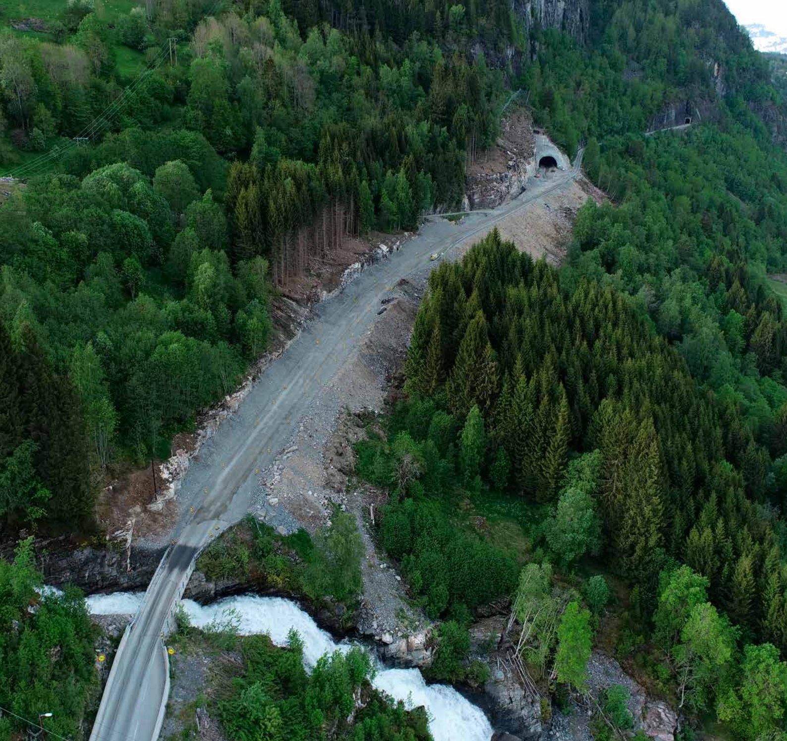
Frå bygging av Blaksettunnelen fv. 5742. Foto: Kai-Henry Hagen.
