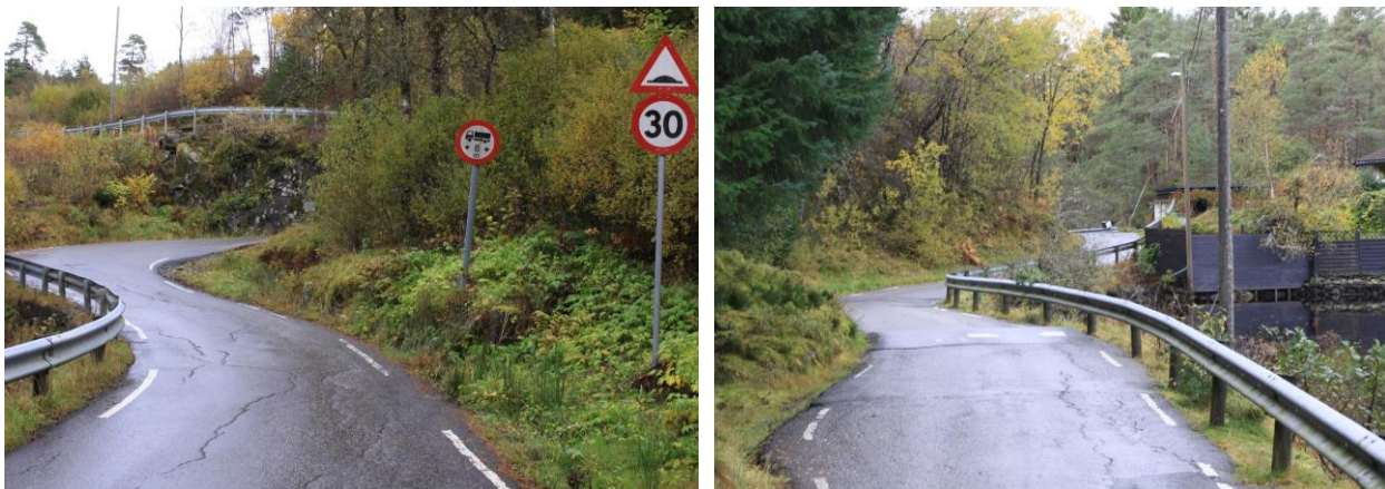
Figur 6-3: Bilder fra Grimseidvegen (kommunal veg). Foto: Norconsult, oktober 2020.
