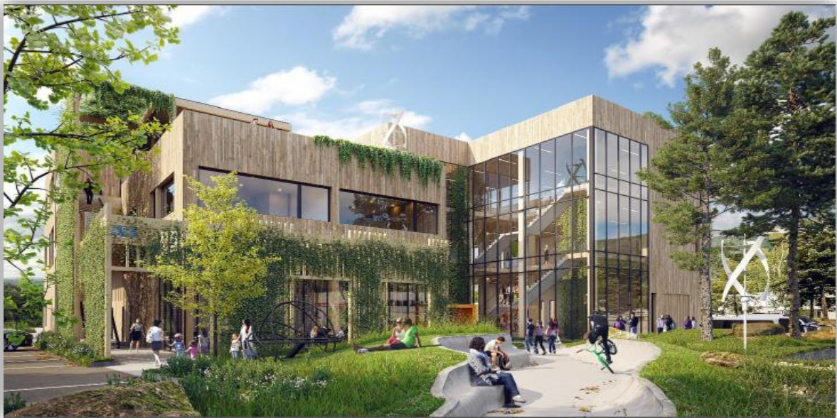
Bilde: Sogndal VGS og ViteMeir. Byggherre Vestland fylkeskommune. Entreprenør Åsen & Øvrelid AS.
