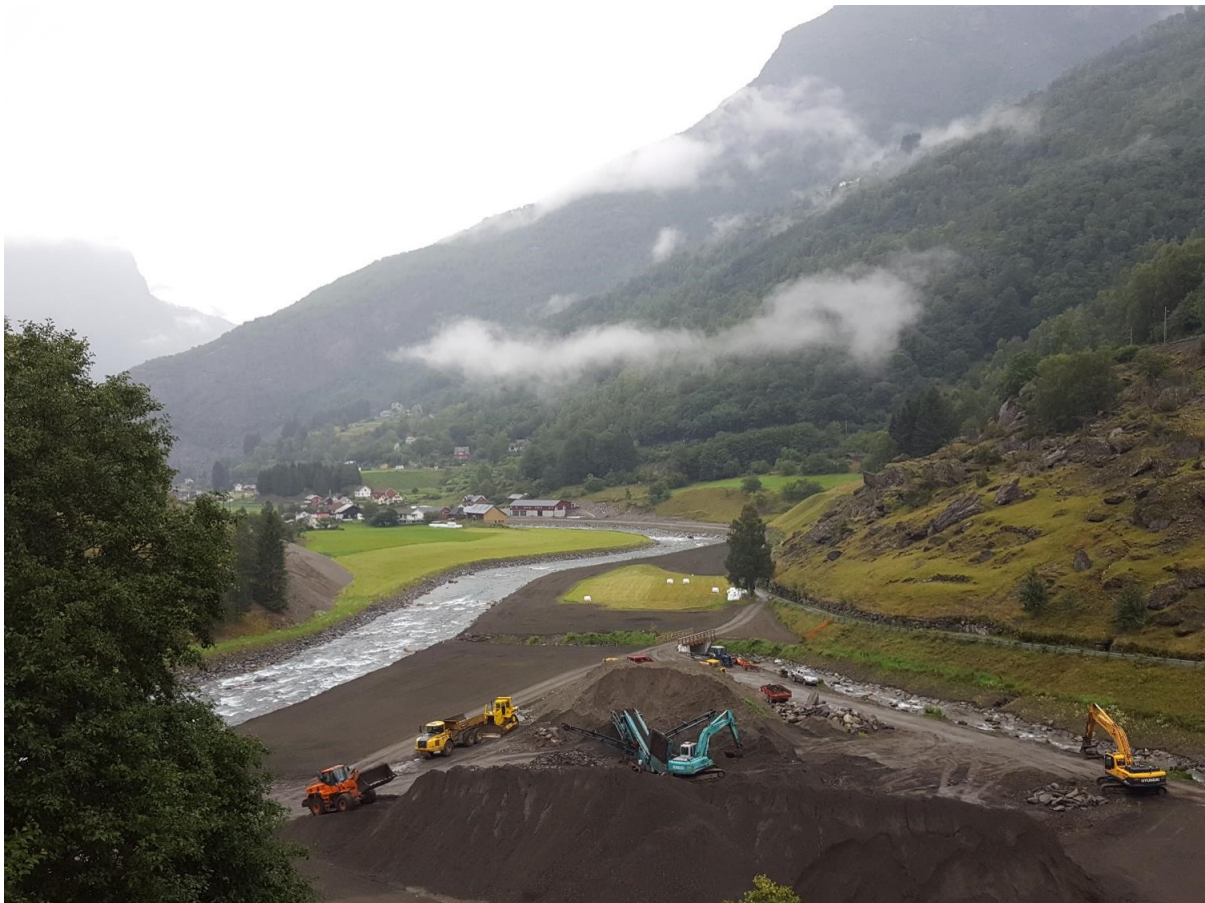
Bilete 7. Sikringsarbeid mot flaum i Flåmselvi. Foto: John A. Gladsø.
