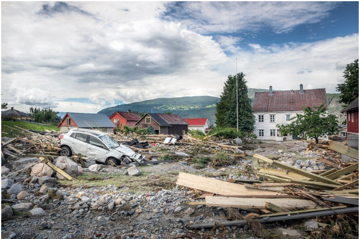
Bilete 1. Natt til 24. juli 2017 regna det svært mykje, og Utvik i Stryn kommune vart råka av flaum. Uveret gjekk hardt ut over fylkesveg 60, og to bruer vart øydelagde. Foto: Silje Drevdal/Statens vegvesen.
