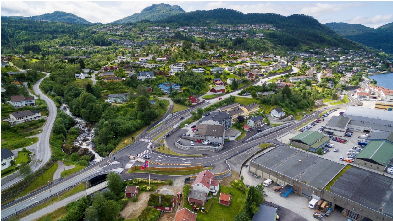
Foto frå tiltak 6&7 i Førdepakken, Askvollkrysset, opna 27.juni 2019:
