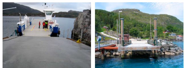
Figur 5 5: Mjåneset ferjerampe, Gulen og Losna ferjekai, Solund (Bruarkiv Statens vegvesen)
