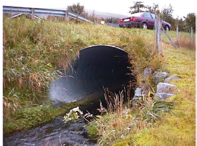
Figur 3 3: Korrugert rør i fylling: Fv. 620 Leikanger i Stad kommune. (Bruarkiv Statens vegvesen)
