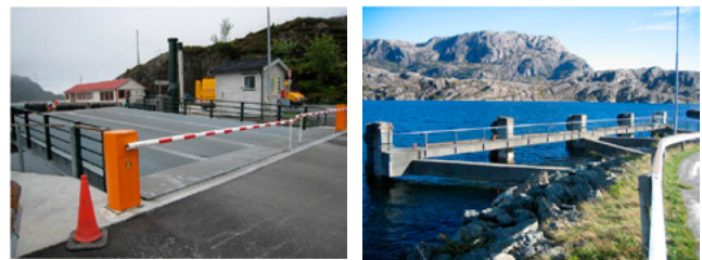
Figur 5 3: Krakhella ferjekai og Krakhella liggekai, Solund (Bruarkiv, Statens vegvesen)
