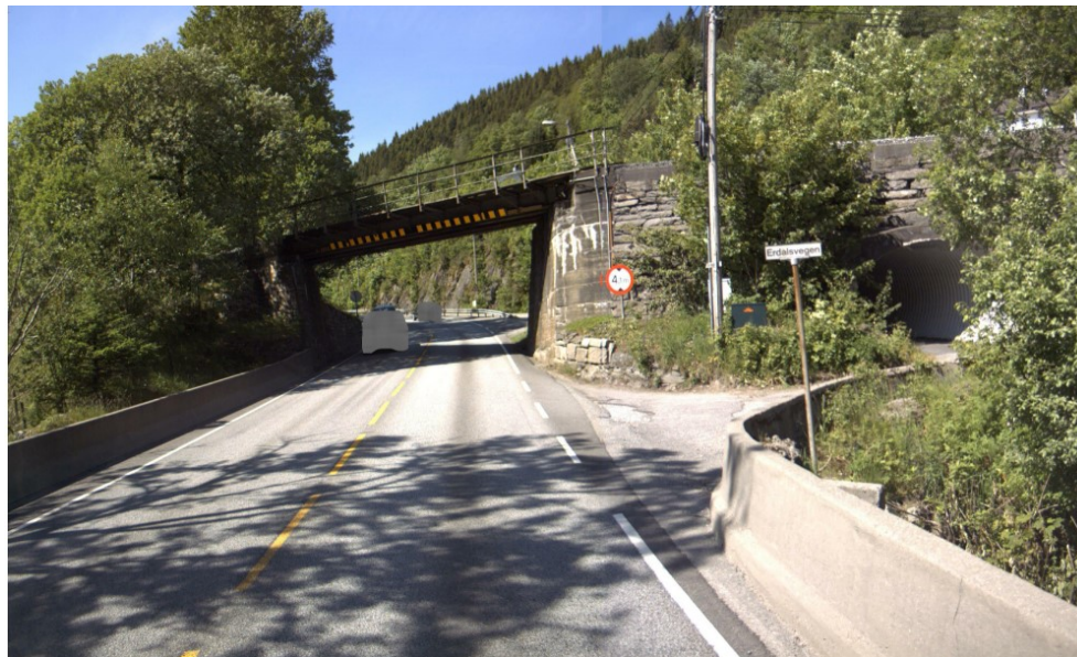
Figur 16 Jernbanebru. Fri høgde 4,1 m.
