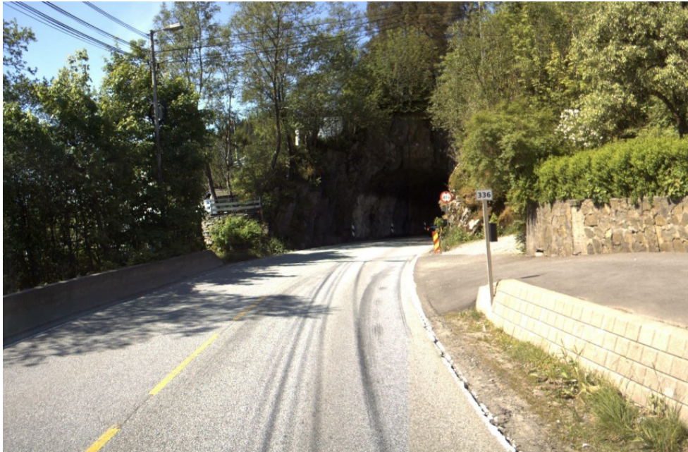
Figur 15 Uoversiktlig avkøyrsløse ved Brattlandtunnelen
