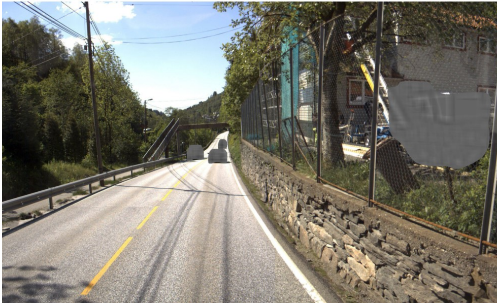
Figur 19 Dårlig utforma fotgjengarbru ved Helldal skule
