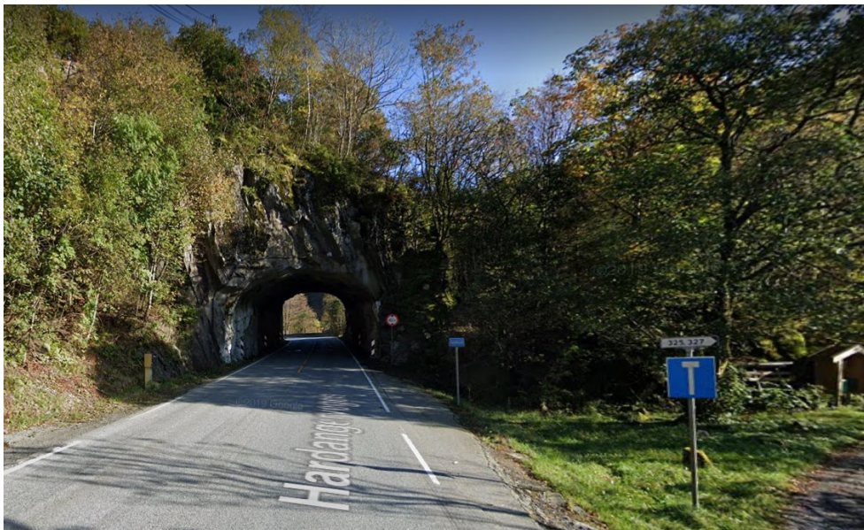
Figur 2 Haldeplass for buss i Grimesvingane
