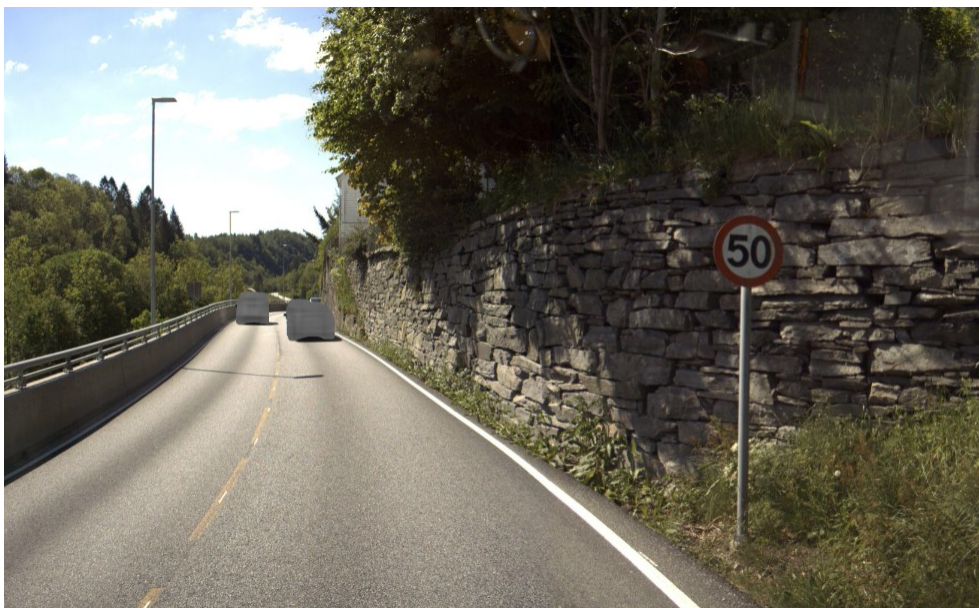
Figur 20 Forsterka rekkverk og vegmur på venstre side
