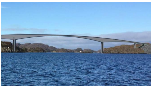
Figur 4: Bru over Ytre Steinsund.
