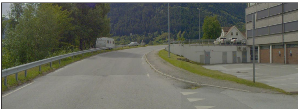
Bilde 1: Fv. 5613 Dalavegen i Sogndal – smalt og slitt fortau
