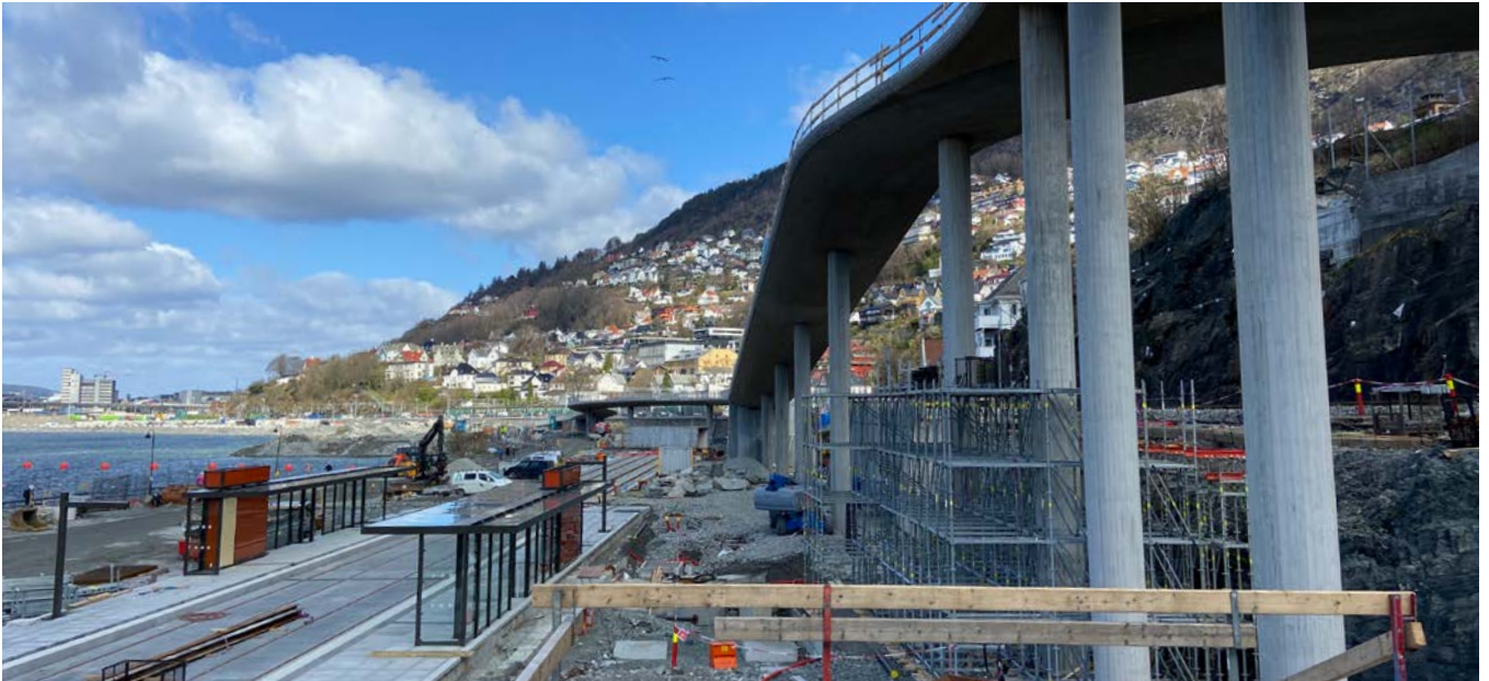
Bybanen til Fyllingsdalen under bygging. Trasé, holdeplass og sykkelveg i Fløen begynner å ta form. Foto: Bybanen utbygging
