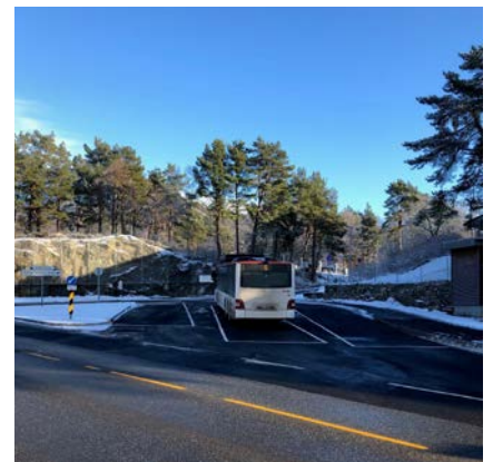
Ferdig 2020: Snuplass Vadmyra. Foto: VLFK
