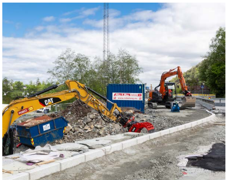
Under bygging: Endeholdeplass trolley på Lyngbø. Foto: Silje Drevdal
