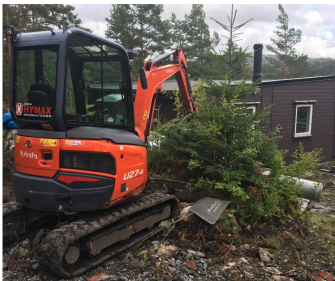
Parkert gravemaskin på gbnr 21/237
