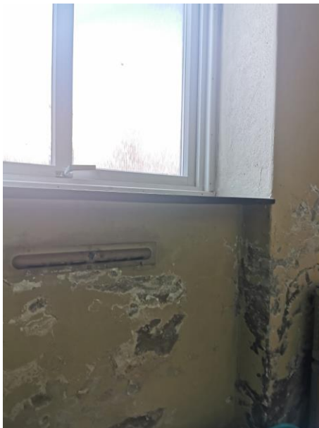
Engelsk hullmur av tegl Kalk/salt- utfelling.
