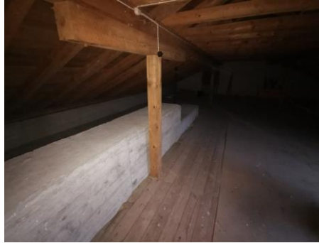
Ventilasjonsjakt over loft i tegl
