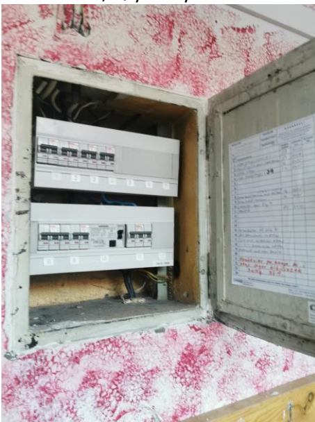
Elektrisk anlegg – Nye automatsikringer eldre ledere, høyt utnyttet kurser.
