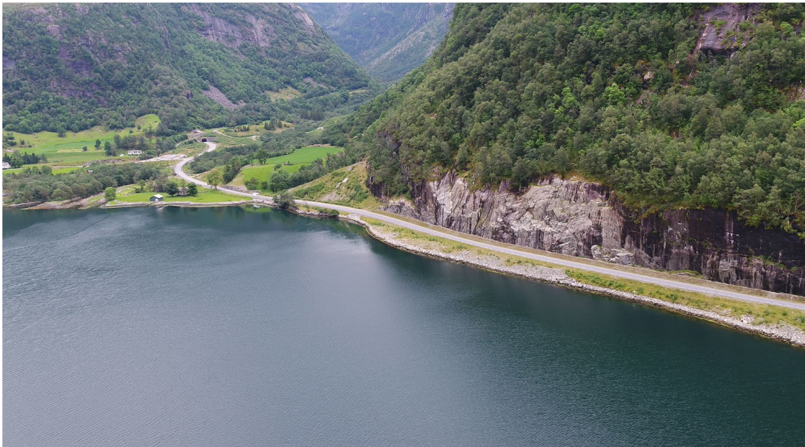
Figur 3-4: Biletet viser området ved påhugg B i Nordrepollen. Jondalstunnelen i bakgrunnen i biletet.
