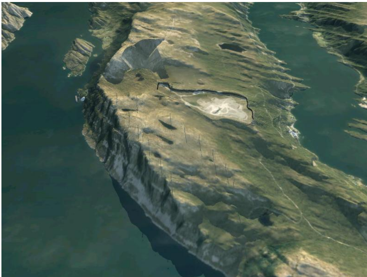
Figur 6-11 Syner tiltaket etter uttak, sett frå lufta frå vest, samt vindmøllepark i forkant og pågåande steinbrot vist mellom Akslabrotet og vindmølleparken.
