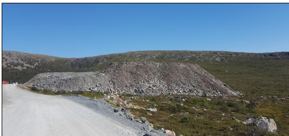
Figur 6-4: Lagring av fjellreinskemassar ved eksisterande brakkerigg for Dyrstad-anlegget. Foto: Multiconsult .
