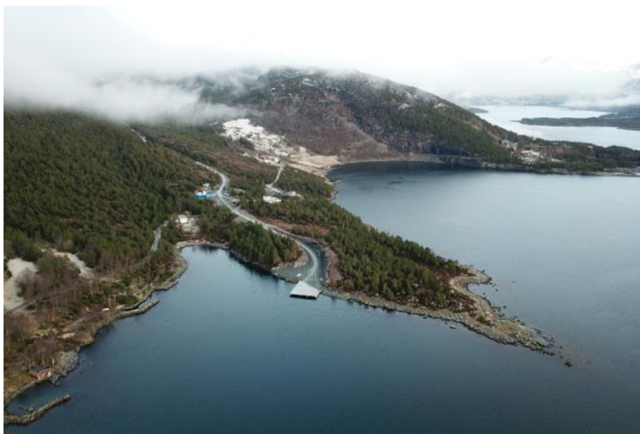
Figur 5-12: Kai ved Djupevika som er etablert i samband med utbygging av vindkraftanlegget på Marafjellet. Denne vil fungere som tilkomst for tungtransport opp til Aksla.
