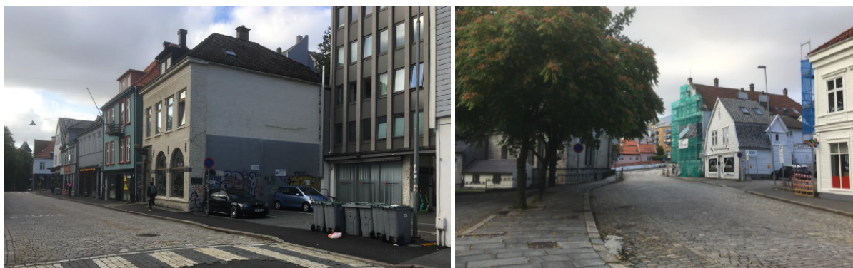
Figur 17. Venstre: Utgang i Lodin Lepps gate. Høgre: Utgang nær Mariakirken. Henta frå rapporten Oppsummering av skissefasen for tunnelalternativet gjennom sentrum.
