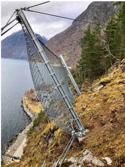
Bilde 21: Rassikring ved Årøyne; Foto: VLFK
