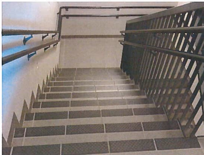
Figur 41 Tydelig markering av trappeneser
