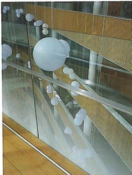
Figur 44 Glassrekkverk med innlagt raster (foto:L.Aasness)
