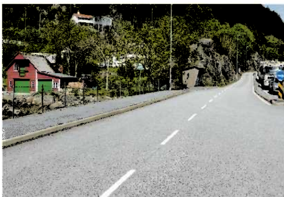
Figur 10 Lehus er plassert feil i forhold til
