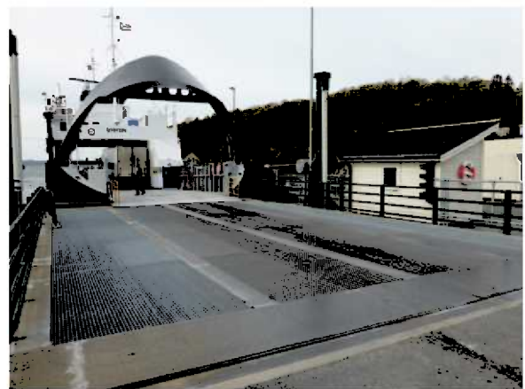
Figur 6 Bred ferjelem. Gitterrist.
