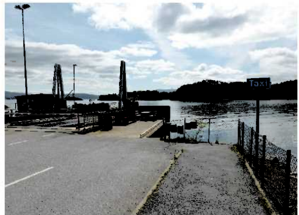
Figur 9 Kaikant som ikke er sikret mellom holdeplass og ferjekai
