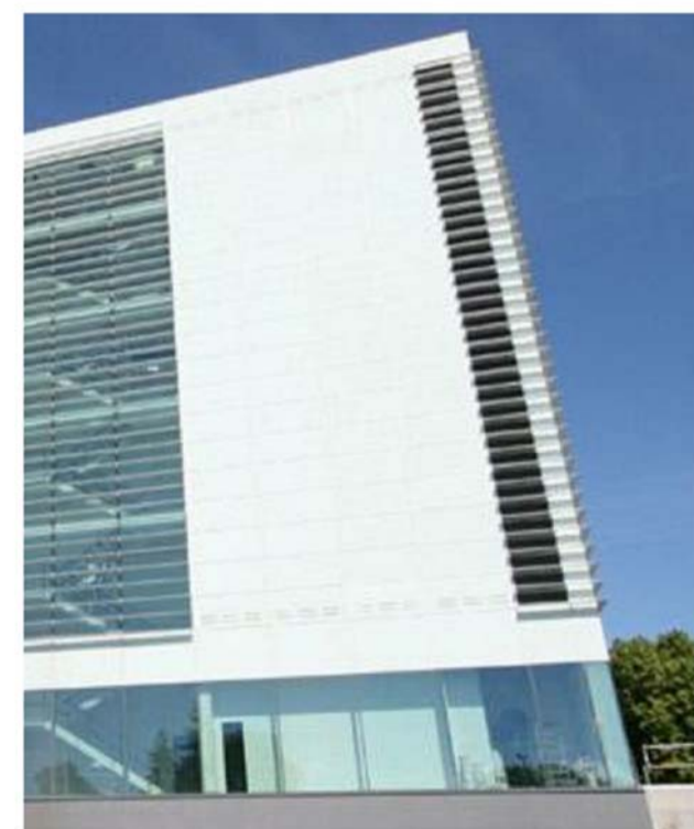
Alu/glassfasader RAL 9010 med emaljerte glassplater på tettfelt i fasaden
