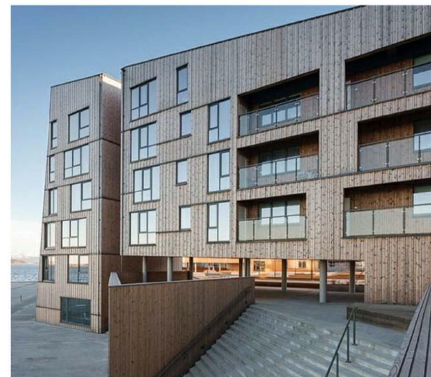
Termofuru fra Moelven. Eksempelet viser vannkanten i Stavanger som er nyoppført. Trevirket har allerede begynt å gråne og vil få en helt lys grå og jevn patina
