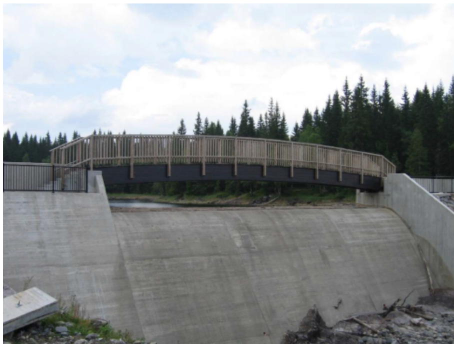
Figur 5 Eksempel på gangbru over dam med flaumoverlaup. Dammen i prosjektet vert mindre, 4 meter høg og 32 meter lang. Fylkesrådmannen meiner anna byggemateriale og annan fargebruk bør vurderast.
