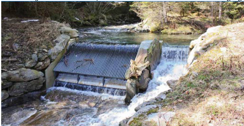
Figur 6: Døme på Coanda-inntak (frå konsekvensrapporten for Matlandselva).
