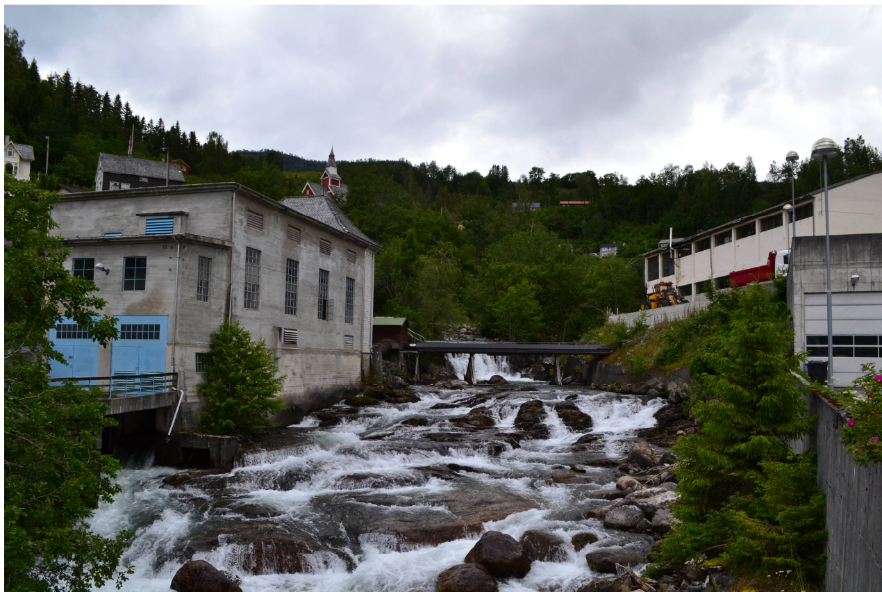
Figur 3 Kraftstasjon Ulvik 1 med middels vassføring under synfaring 16.07.15. Med stor nok minstevassføring kan anadrom strekning forlengast med om lag 150 m ovanfor utløpet på kraftstasjonen til venstre. Kraftstasjonen har høg kulturminneverdi.
