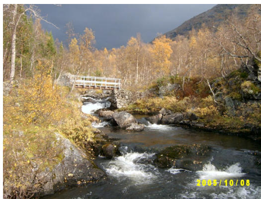
Fig. 7 Gangbru over del av Isdøla som bli påverka av tiltaket.
