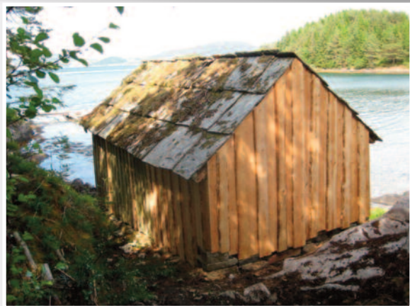
Ferdig restaurert 23.juni
