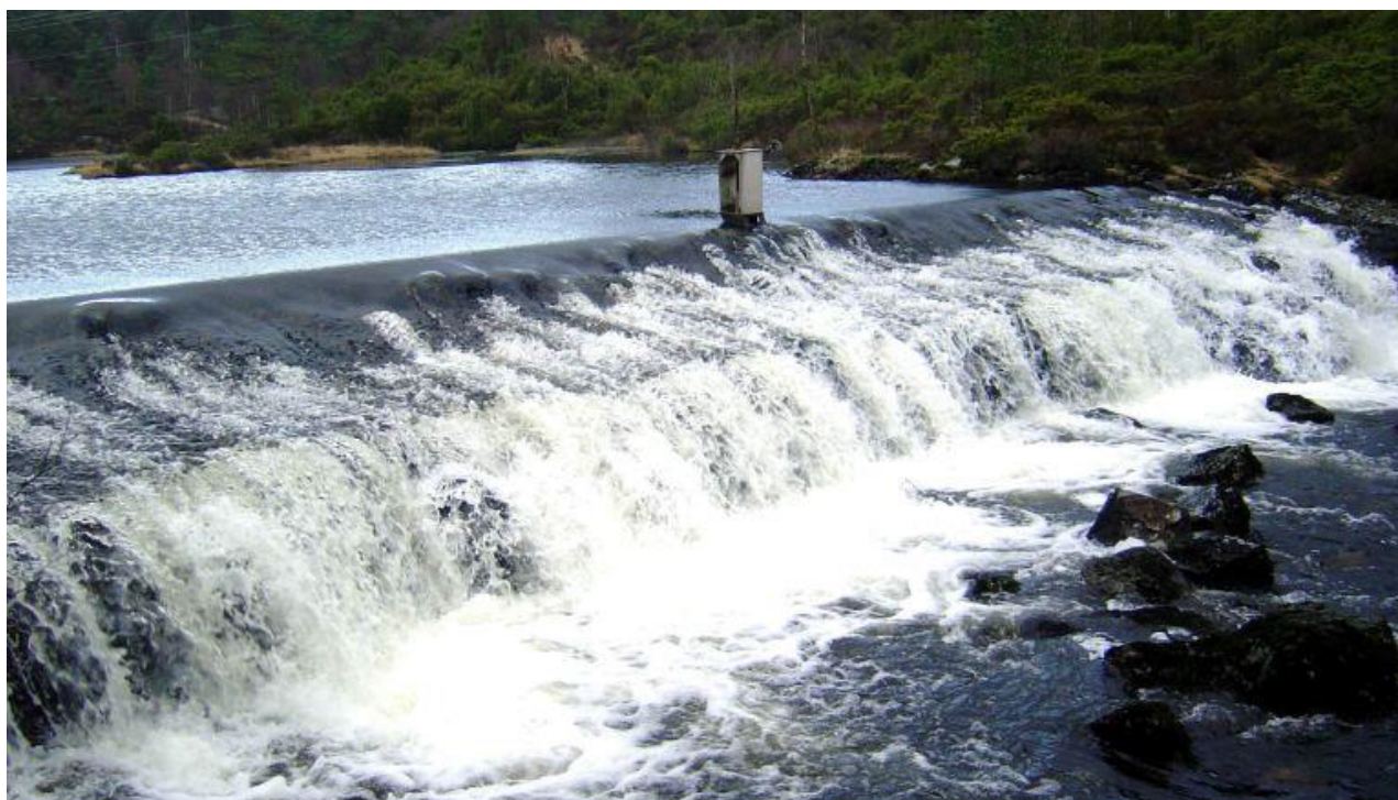
Figur 2. Den gamle stemma i utløpet av Onarheimsvatnet, der innsjøen kan senkast med inntil 1,5 meter.
