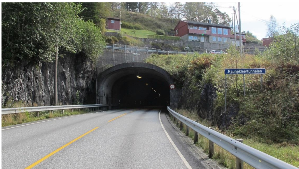
Figur 6: Bildet er tatt ca. 10 meter fra tunnelåpningen. Da bildet ble tatt var lysforholdene tilnærmet lik ulykkesdagen. Foto: SHT
