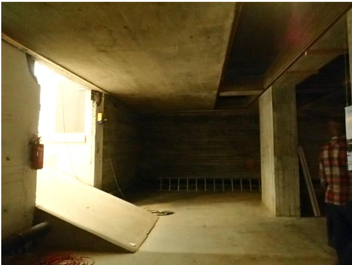
Bilde: Kjeller i nord-øst mot tilfylt kjellervegg med synlig søyle
