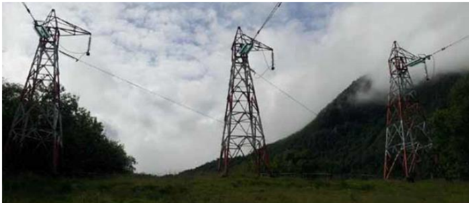
Figur 4: 132 kV fjordspennmast som er planlagt over Austgulfjorden.
