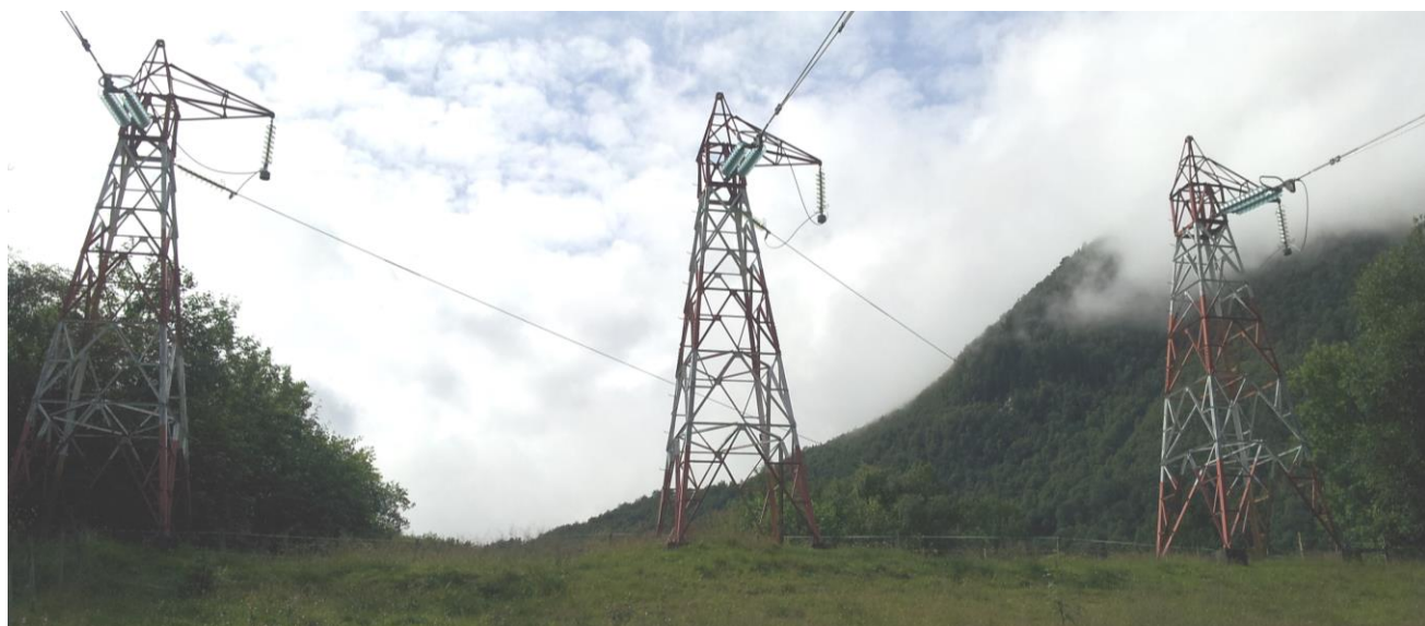
Figur 10. Eksempel på 132 kV fjordspennmaster.
