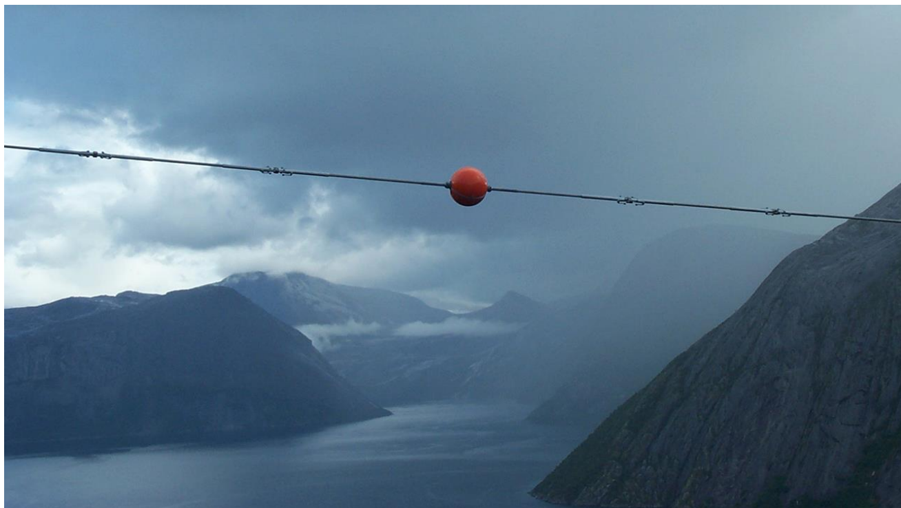
Figur 14. Flymarkør på kraftledning.
