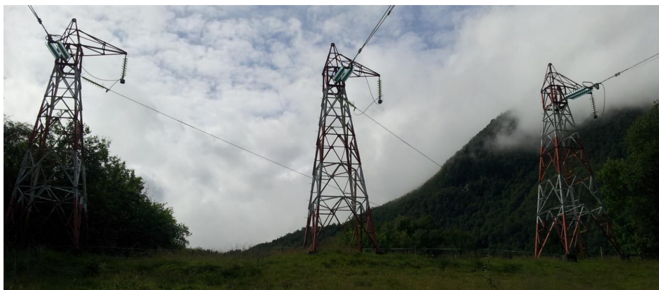
Figur 10. Eksempel på 132 kV fjordspennmaster.
