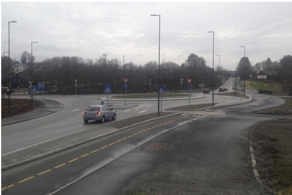
Figur 13: Fv. 546 Fanavegen x Krokeidevegen ved Kirkevoll skole. Planfri kryssing (undergang) og rundkjøring med gjennomgående sykkelløsning er det mest omfattende enkeltstående trafikksikkerhetstiltaket som ble ferdigstilt i perioden 2014-17. Planfri kryssing gir et meget sikkert tilbud til skoleelever fra Krokeide-siden som skal til/fra Kirkevoll skole
