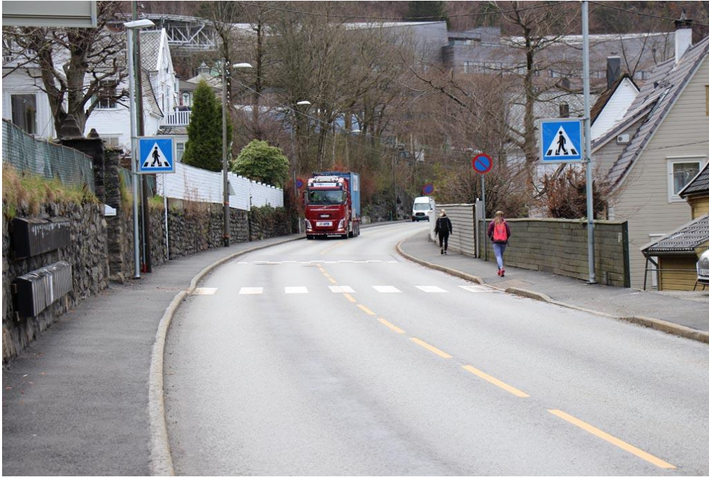
Figur 14 Fv 255 Ibsens gate øvre del er opprustet med bredere fortau, resetting av kantstein, nytt gangfelt samt fartsdempende tiltak. Oppgraderingen har skjedd i samarbeid med Bergen kommunes VA-etat som skifter ut ledningsnettet i hele Ibsens gate i perioden 2016-19
