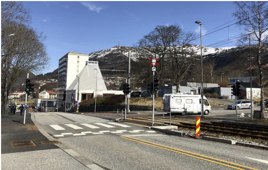
Figur 12: Signalregulering Fv.251 Vilhelm Bjerknesvei ved Bergenshallen. Signalregulering av krysset forventes å gi økt trafikksikkerhet for alle trafikantgrupper. Løsningen gir bybanen prioritet gjennom krysset etter samme system som øvrige kryss mellom veg og bybane, og forventes dermed å gi bedret framkommelighet (bl.a. færre nødbrems) for bybanen
