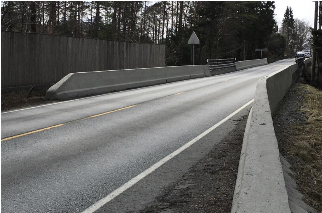
Figur 15: Rekkverkstiltak Fv.580 Hardangervegen ved Espeland i Arna. Her er etablert betongrekkverk/brorrekkverk på utsatte punkt hvor eksisterende rekkverk var av dårlig kvalitet og der evt. utforkjøring vil kunne medføre høy skadegrad.
