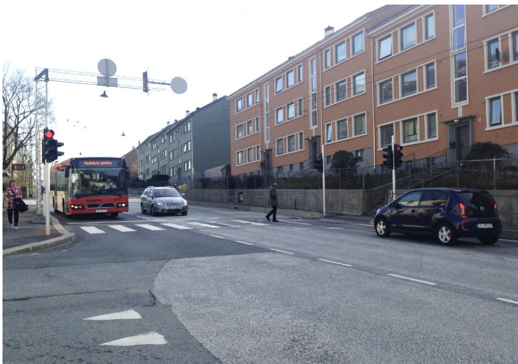
Figur 18: Signalregulering Fv. 585 Nattlandsveien x Landåsveien. Her har tidligere vært registrert mange trafikkulykker, og signalreguleringen forventes først og fremst å bidra til færre fotgjengerulykker. Fjerning av fotgjengerrepos tillater buss ut fra holdeplass å fortsette rett frem i kollektivfelt uten svingemanøvrer
