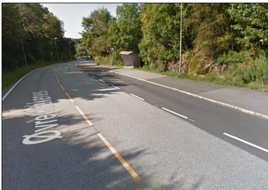
Figur 9: Bilde av tidligere utforming som busslomme - Kråkenestoppen retning Fyllingsdalen (kilde: Google Maps)
