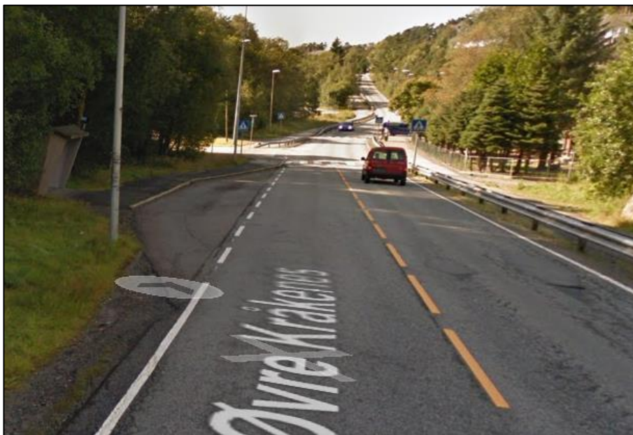
Figur 7: Bilde av tidligere utforming som busslomme - Bønes skole - retning Fjøsanger (kilde: Google Maps)
