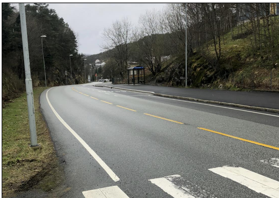
Figur 8: Bilde av dagens kantstopp - Kråkenestoppen - retning Fyllingsdalen
