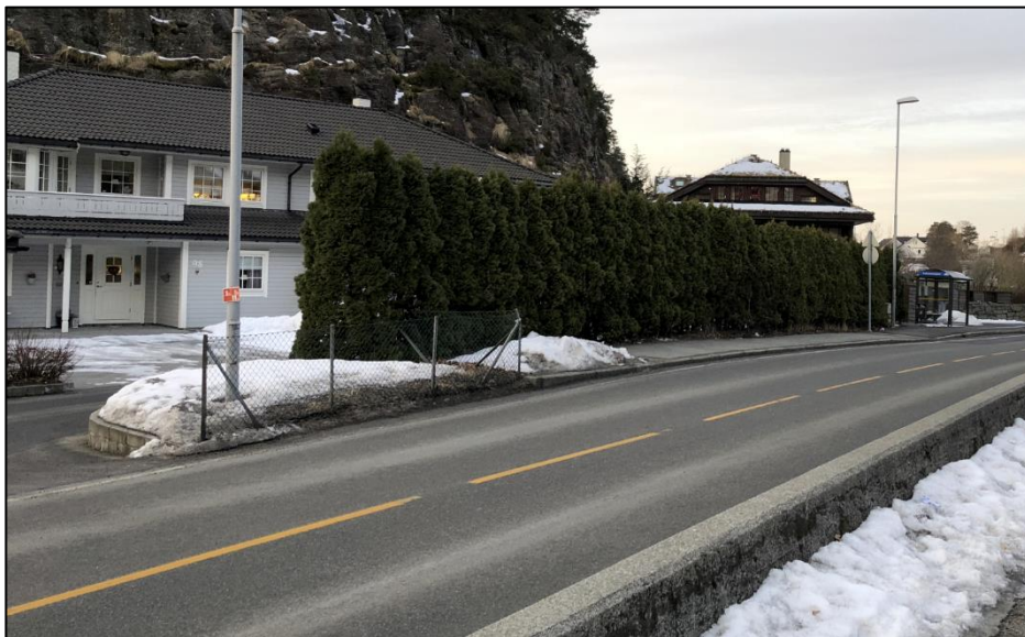
Figur 14: Avslutning av fortau i forkant av avkjørsel til boligområde
